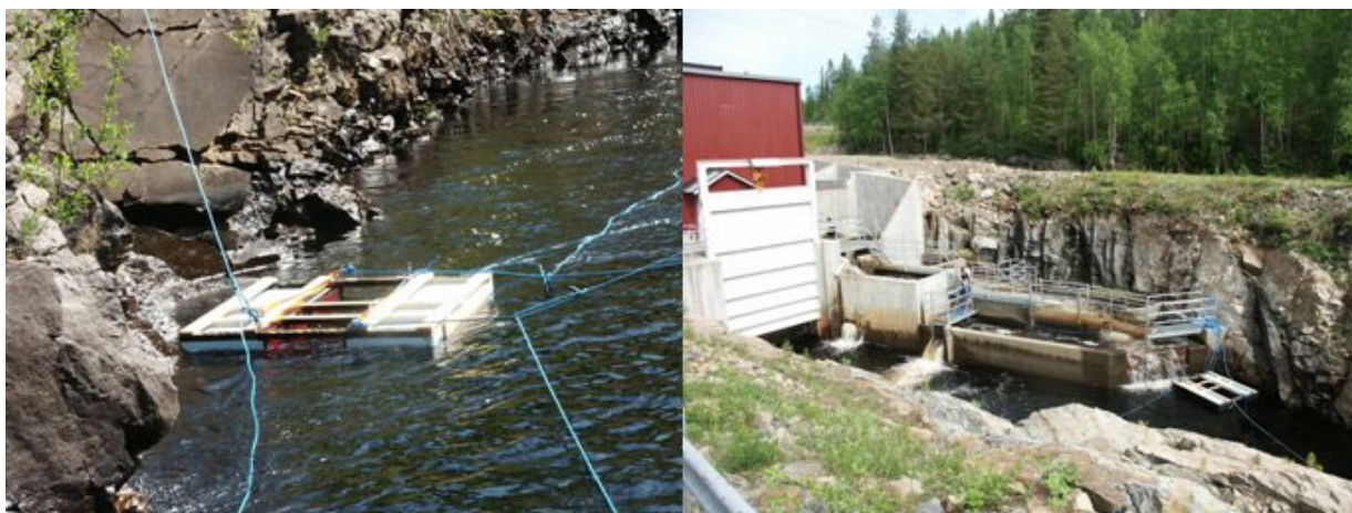
Figur 9: Flytande lockvattenanordning vid Hednäs kraftstation i Åbyälven.
