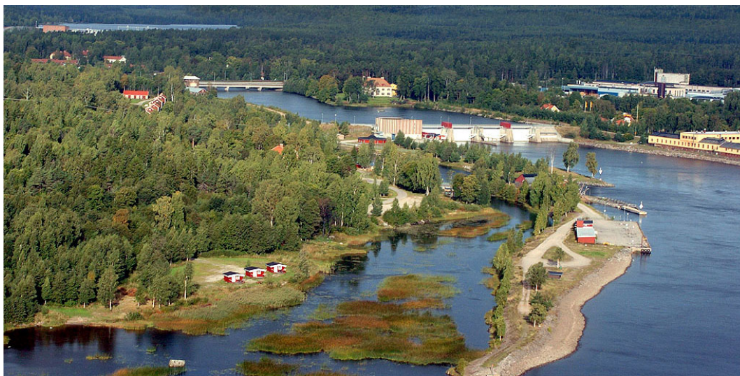
Ljusnefors kraftverk i Ljusnan. Bild: Fortum
